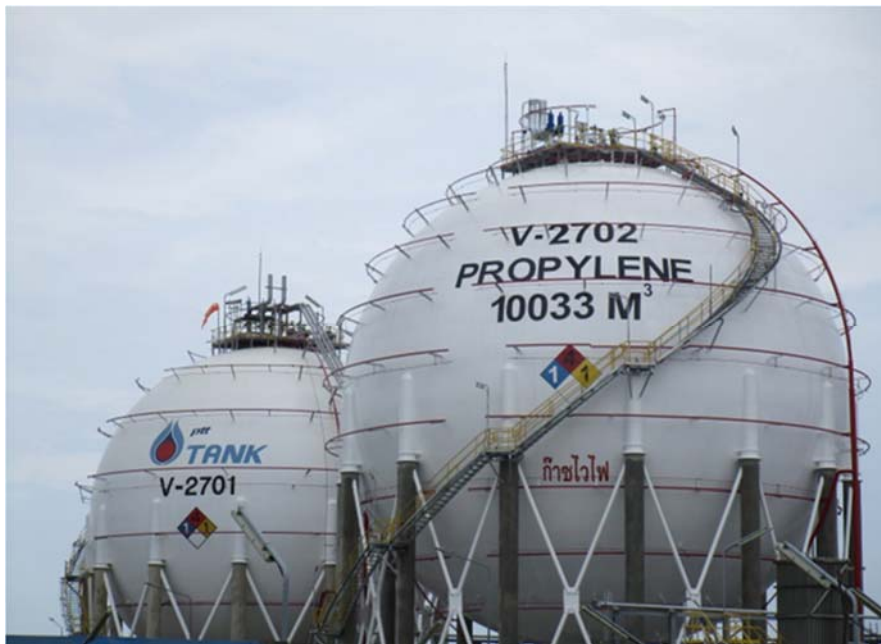
ชื่องาน: PTT Tank Terminal
