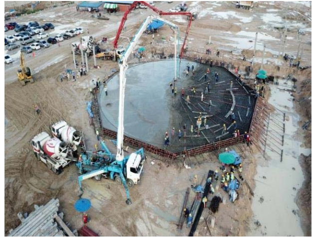
ชื่องาน: PTT LNG Nongfab Civil
