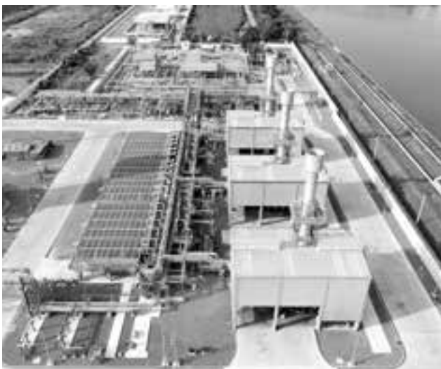
▲ ชื่องาน: PTT Wangnoi Compressor Station
