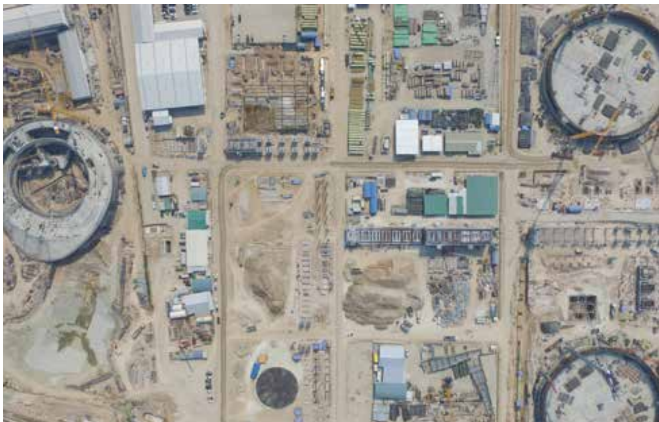
PTT LNG Nongfab LNG Receiving Terminal (Civil)
